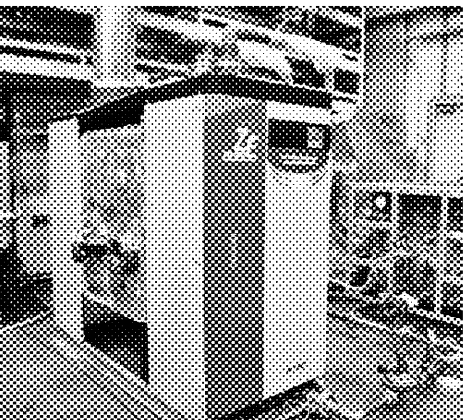
京都工場では貯蔵容量が最大280m 3 の水素カードルを設備し、水素燃料対応の製品開発を行っている
